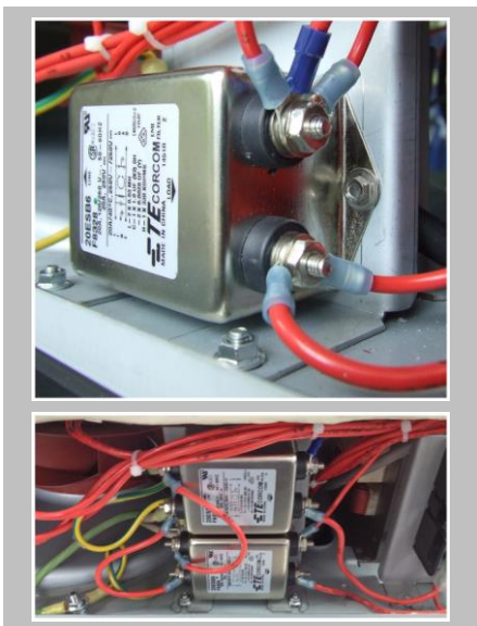
Øverst: én EMC-filterenhed (1000W e2s-variant) Nederst: to EMC-filterenheder (2000W e2s-variant)
